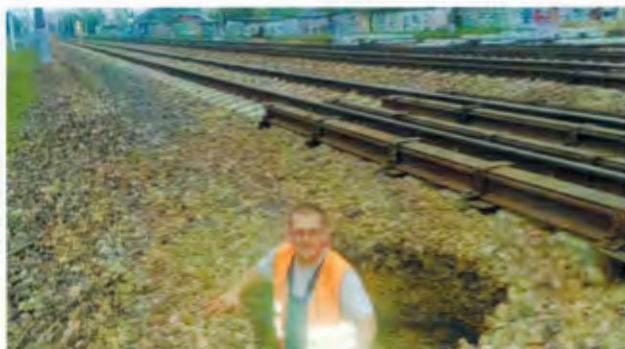
Рис. 9. Нештатная ситуация при производстве работ бестраншейным способом непосредственно в зоне железнодорожного полотна
