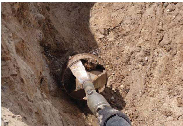
Приспособление для протяжки труб изготавливается из отрезка трубы ВЧШГ с раструбом «RJ» или «RJS»,
